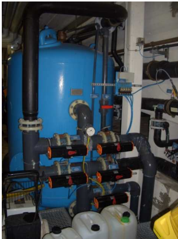
Badewasserbehandlungsanlage, hinter dem Filter (blau)
